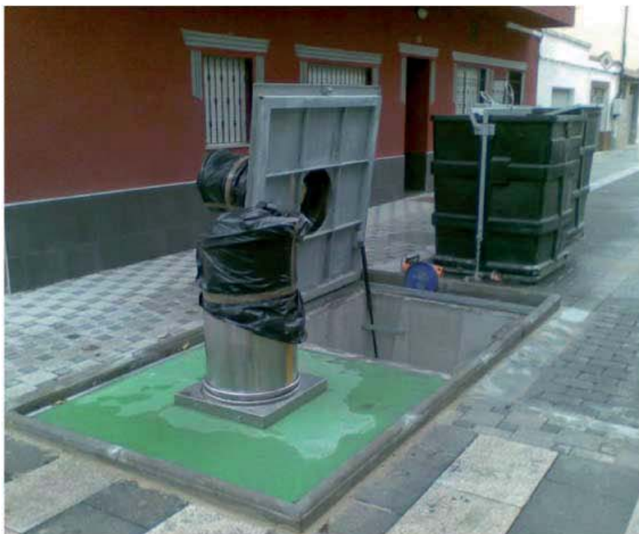
Se impermeabilizaron los cubetos a contrapresión para evitar la entrada de agua en los contenedores.
