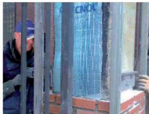
Los pilares se forraron con TQ TECNOTERMIC A3.
