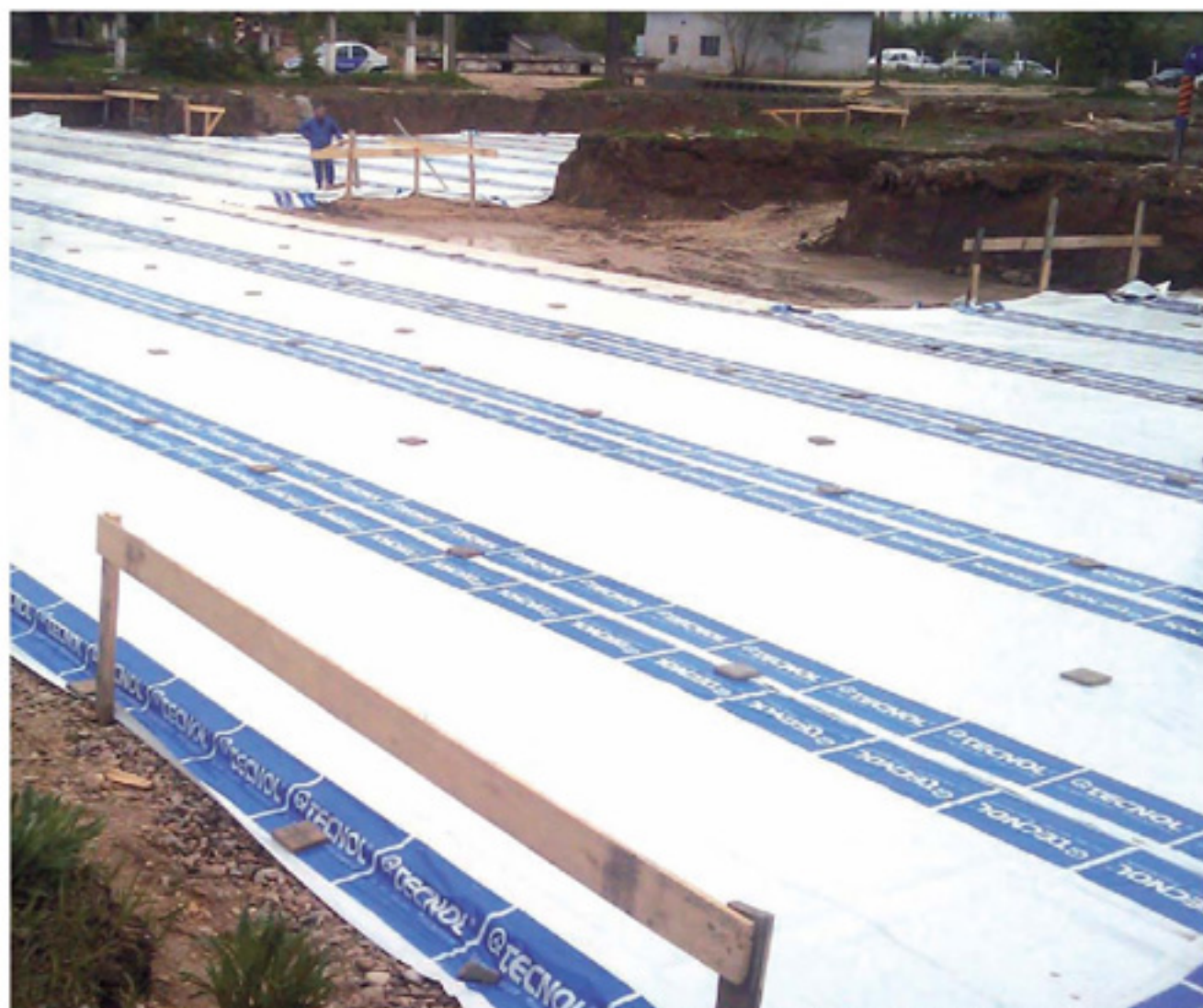
TQ TECNOFILM es una lámina de polietileno que evita posteriores apariciones de humedades por capilaridad procedentes del subsuelo.
