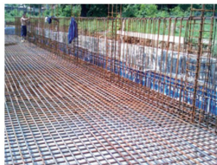
Se impermeabilizaron en total, 2.000 m 2 de superficie.
