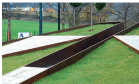
Aspecto final de la rotonda, una vez terminada la obra.
