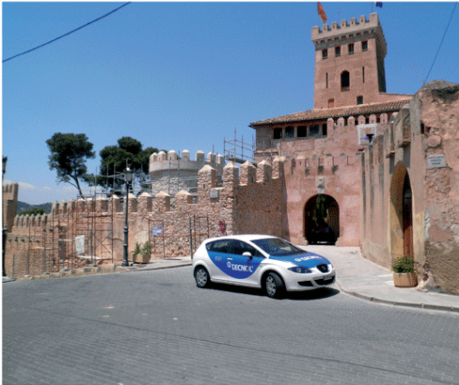
Gracias a la acción limpiadora de TQ DESCANET GEL el torreón recuperó su color original, dañado por el paso del tiempo.
