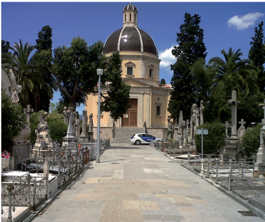
Vista de la capilla del cementerio de Palma de Mallorca donde se hizo la aplicación del producto TQ IMPER POL para evitar filtraciones.
