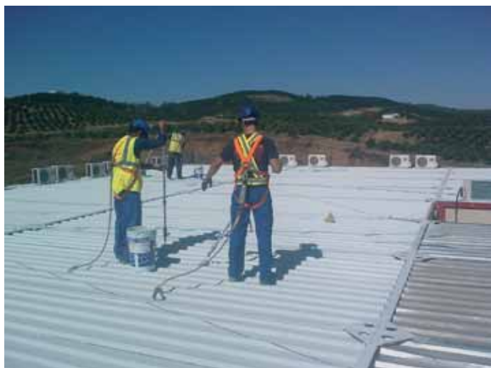
La pintura TQ I-TERMIC, aplicada con rodillo, garantiza el confort térmico en el edificio.
